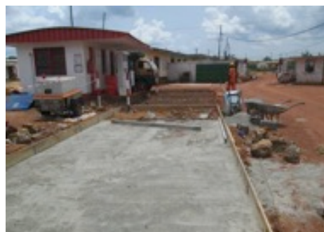
Travaux de dallage de la station TOTAL
