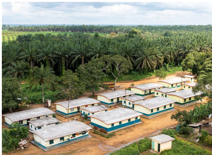
Travaux d'adaptation dans les anciennes maisons en bois du village V2 en 2022, Plantation d'Edéa
