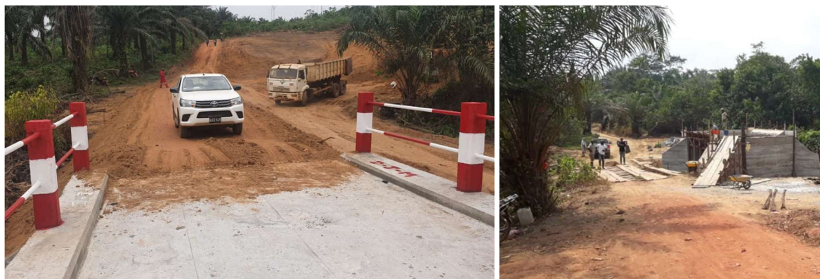
Construction d'un pont reliant des plantations villageoises, Plantation de Mbongo
