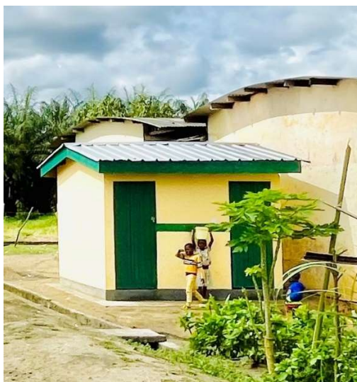
Reconstruction de latrines en 2022, Plantation de Dibombari
