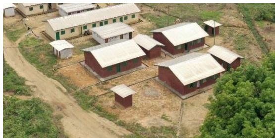
Réseaux d'eaux pluviales intégrés aux nouveaux logements, Plantation de Dibombari
