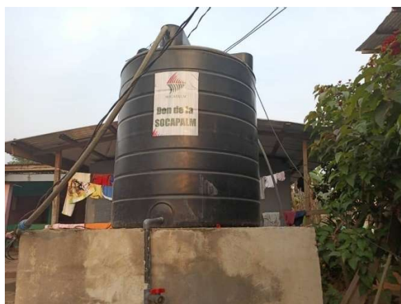
Construction du nouveau château d'eau du village de Bomono Ba Mbengue II, Plantation de Dibombari
