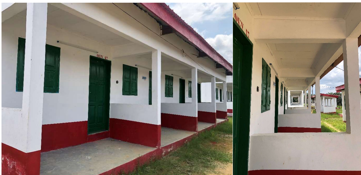
Logements ouvriers, Plantation d'Edéa
