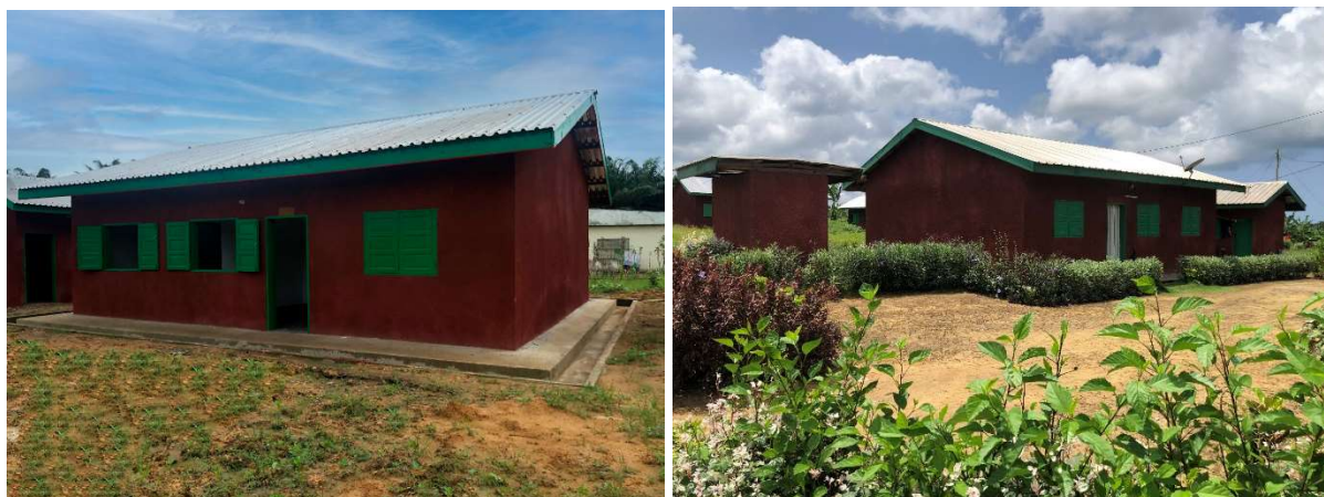
Nouveaux logements, Plantation de Dibombari (à gauche) et Kienké (à droite)
