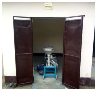
Hangar construit par la Socapalm au marché de Bomono Gare pour le moulin à manioc offert par la Socapalm au groupement des femmes, Plantation de Dibombari
