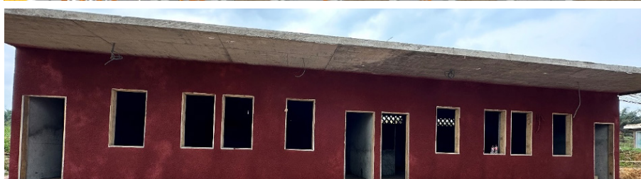
△ Travaux en cours - 2 salles de classe - Collège agricole, Kienké, Socapalm
