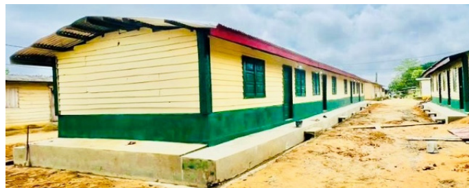
△ Travaux d'adaptation dans les anciennes maisons en bois du village Nkoumé en 2023, Dibombari, Socapalm
