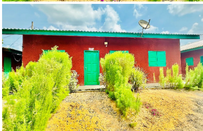
△ Aménagements extérieurs au village de Nkapa, Dibombari, Socapalm
