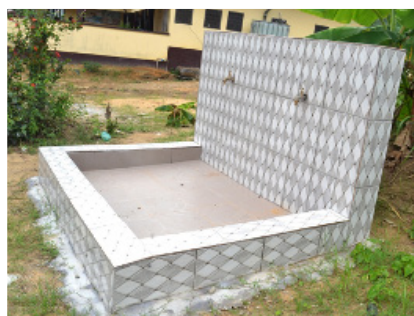
△ Constructions des bornes fontaines dans les villages de Nkende, Bomono Ba Mbengue I, Bomono Ba Mbengue II, Dibombari, Socapalm
